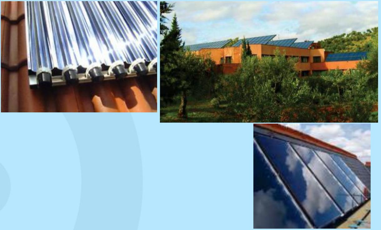
Les capteurs thermosolaires sont destinés à transformer le rayonnement solaire pour chauffer un fluide caloporteur. La chaleur véhiculée par ce fluide est ensuite utilisée pour produire soit de l'eau chaude sanitaire (ECS) soit du chauffage. Le système en lui-même peut être décomposé en 2 parties : la partie captage du rayonnement solaire et la partie production qui transforme cette énergie en chauffage ou ECS.
